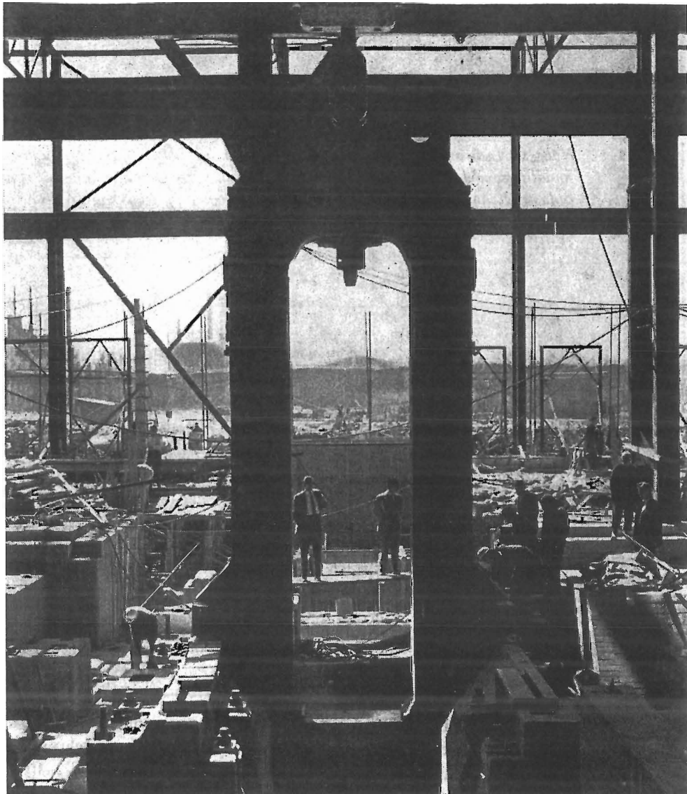
Oxelösunds stålverk under byggnad — ett stort investeringsobjekt.
