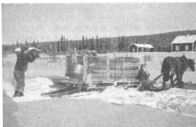
Fig. 9. Vattenlåda med pump för isning av basvägar.
