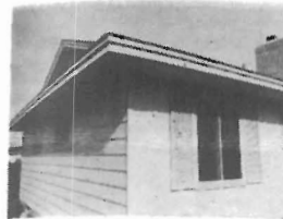
Hängrör och stuprör, skorstensbeslag liksom fönsterblock, saknas på ett standardhus i USA. Fasadbeklädnad är i detta fall av masonit i två utföranden.
